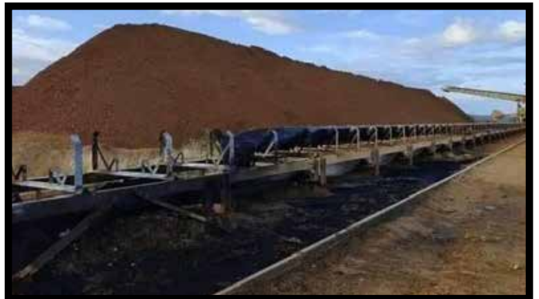
2 juin 2024. Incendie volontaire du convoyeur de nickel à Népoui, alors qu'il devait charger d'urgence un minéralier pour l'usine de la SLN de Nouméa
