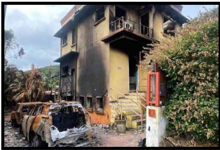
11 juin 2024. Une maison de colon incendiée dans la Vallée-du-Tir (Nouméa)
