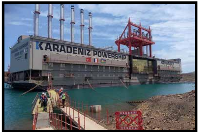
12 juin 2024. La centrale au fioul flottante de l'usine de nickel de la SLN
